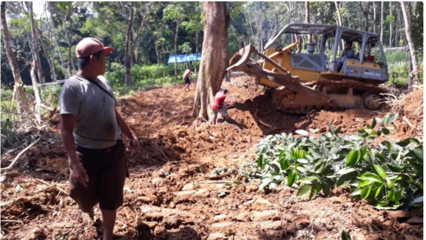
Alat Berat Diturunkan, Pembuatan Badan Jalan TMMMD ke-115 Kodim 1008/Tabalong
