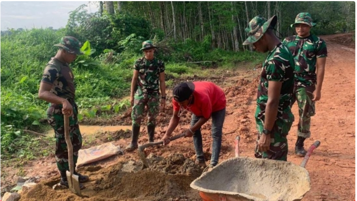
Anggota Satgas dan Warga Bahu Membahu Selesaikan Pemasangan Gorong-gorong
