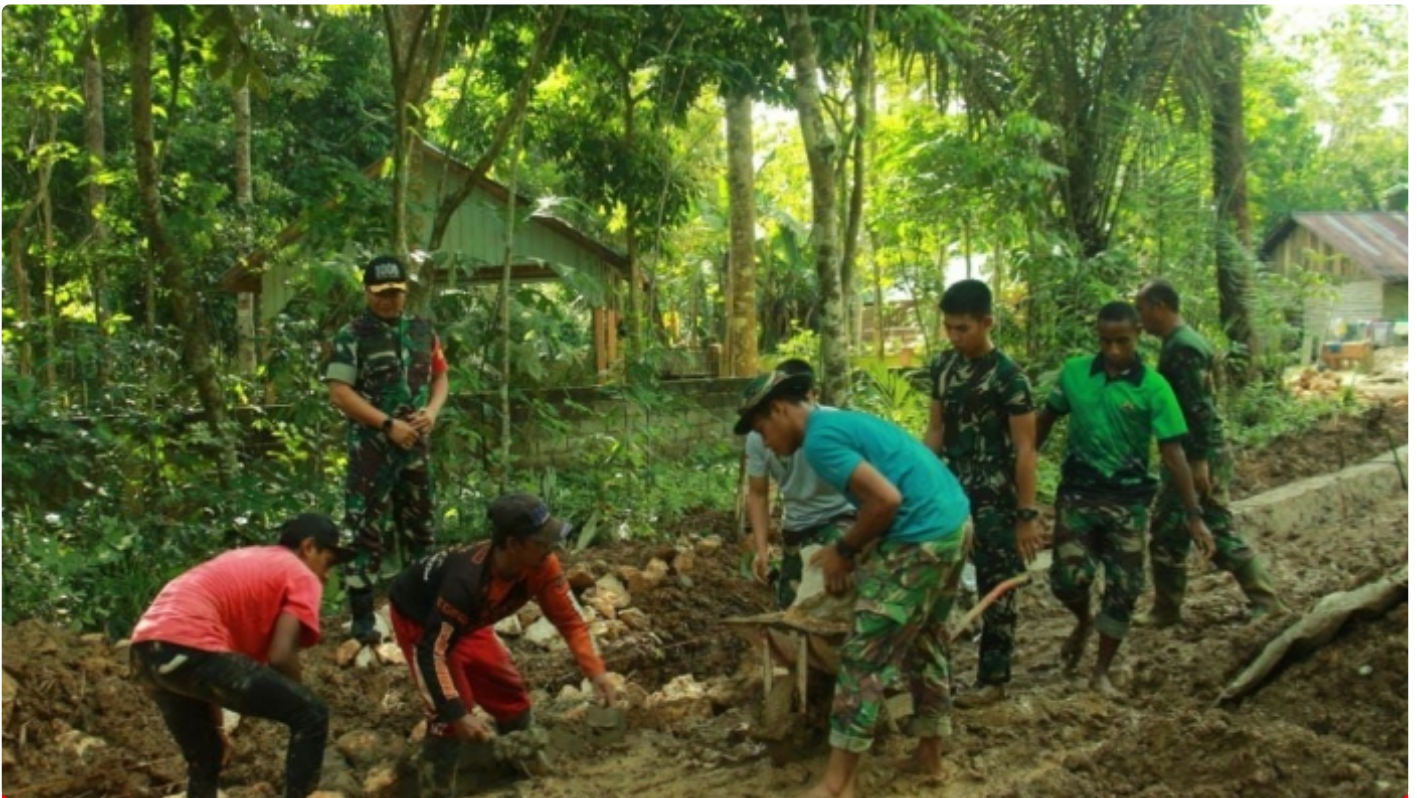
Dansatgas TMMD Kodim 1008 /Tabalong Tinjau Progres Pembuatan Badan Jalan
